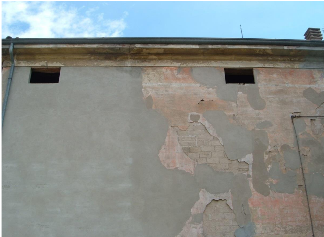
Figura 4. Particolare dei pannelli in foglio e della suo mancante ammorsamento al pilastro di due teste (luglio 2007)
