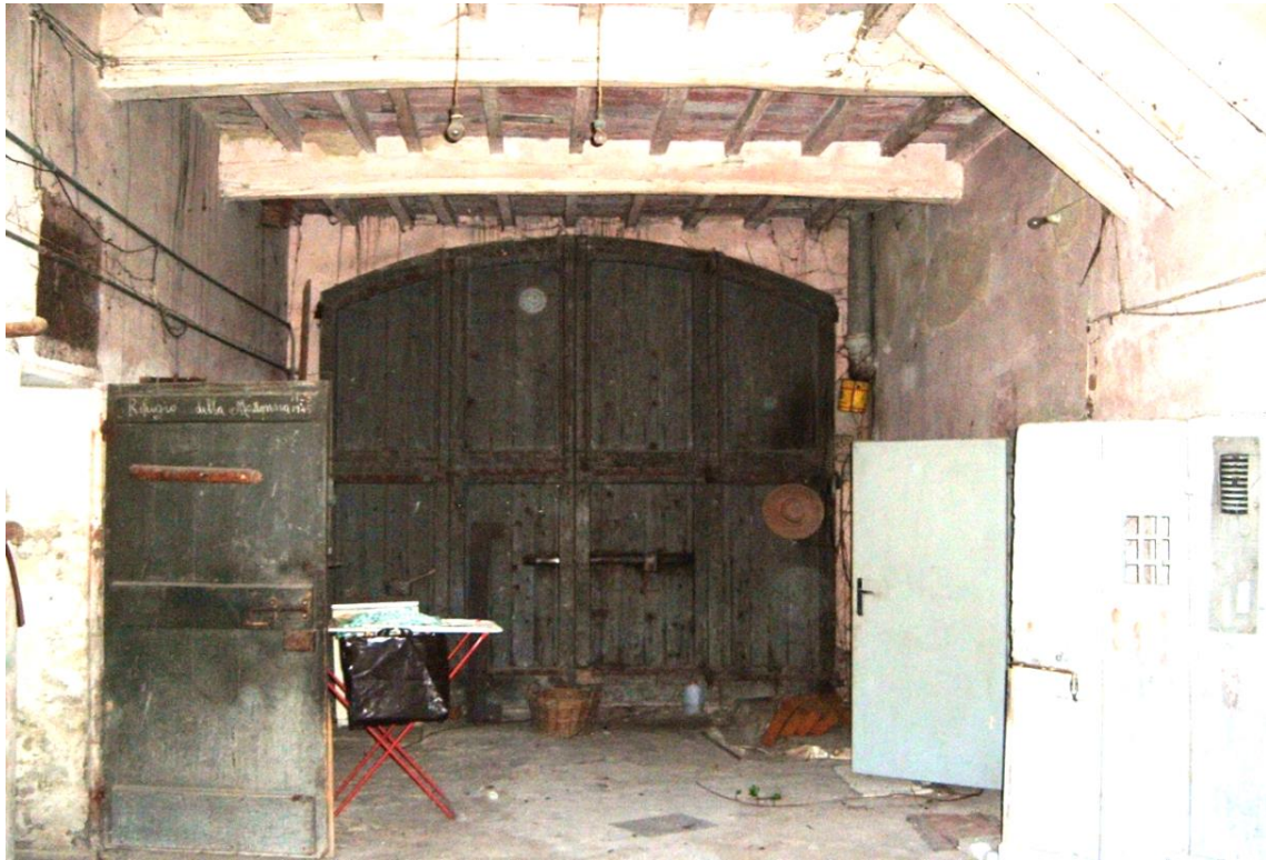
Figura 8. Particolare della porta morta con l'impalcato composto da travi, travetti e tavelle da piano (luglio 2007)
