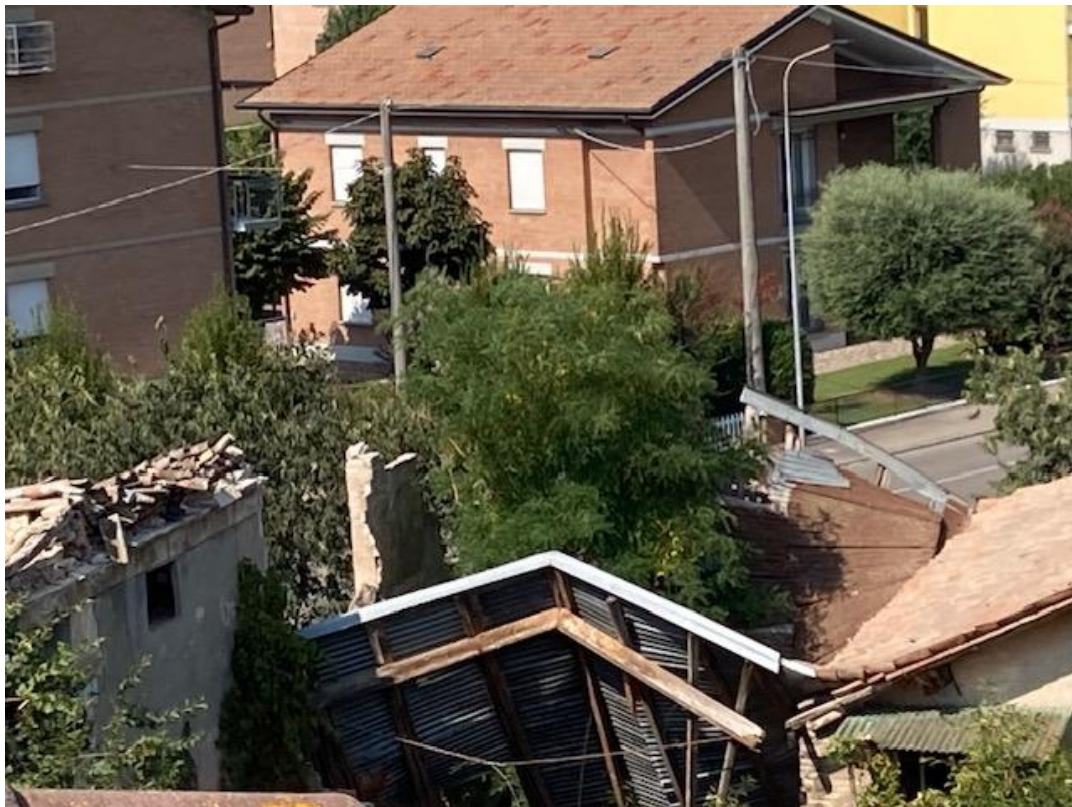
Figure 45 e 46. Vista del porticato fra la crollata stalla e il basso comodo con le strutture implose
