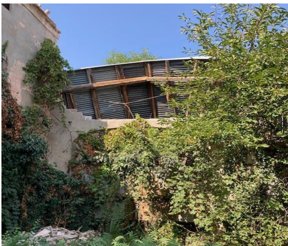
Figure 11 e 52. Il porticato del collegamento imploso
