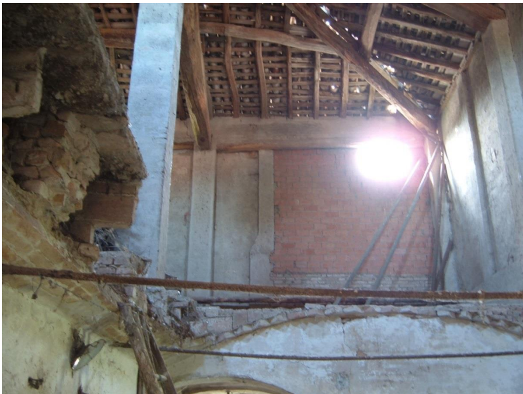
Figura 1. Particolare delle strutture della stalla/fienile prima del collasso complessivo: in primo piano la struttura della volta con laterizi in foglio (luglio 2007)
