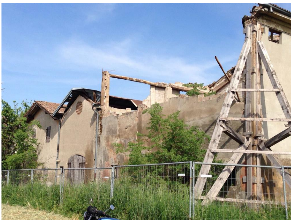
Figura 3a. Il fianco Ovest della parte produttiva dopo la posa dei puntelli per i collassi strutturali (maggio 2016)
