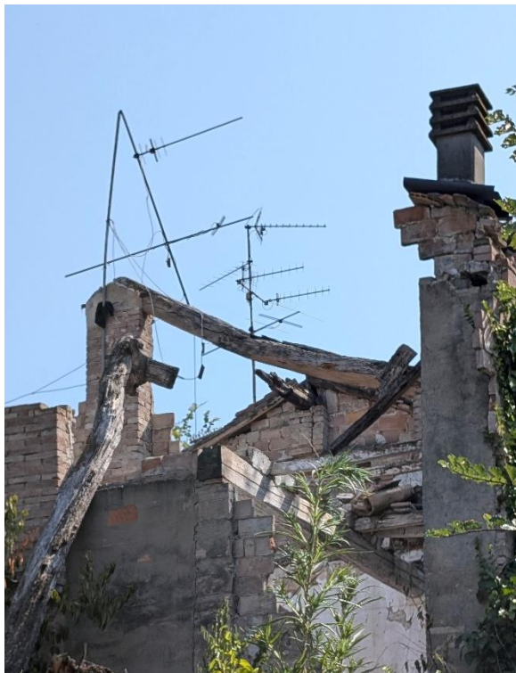
Figura 56. Particolare i crolli nella ex stalla-fienile
