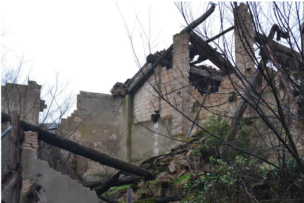
Figura 3b. Il collasso strutturale della stalla (febbraio 2024)
