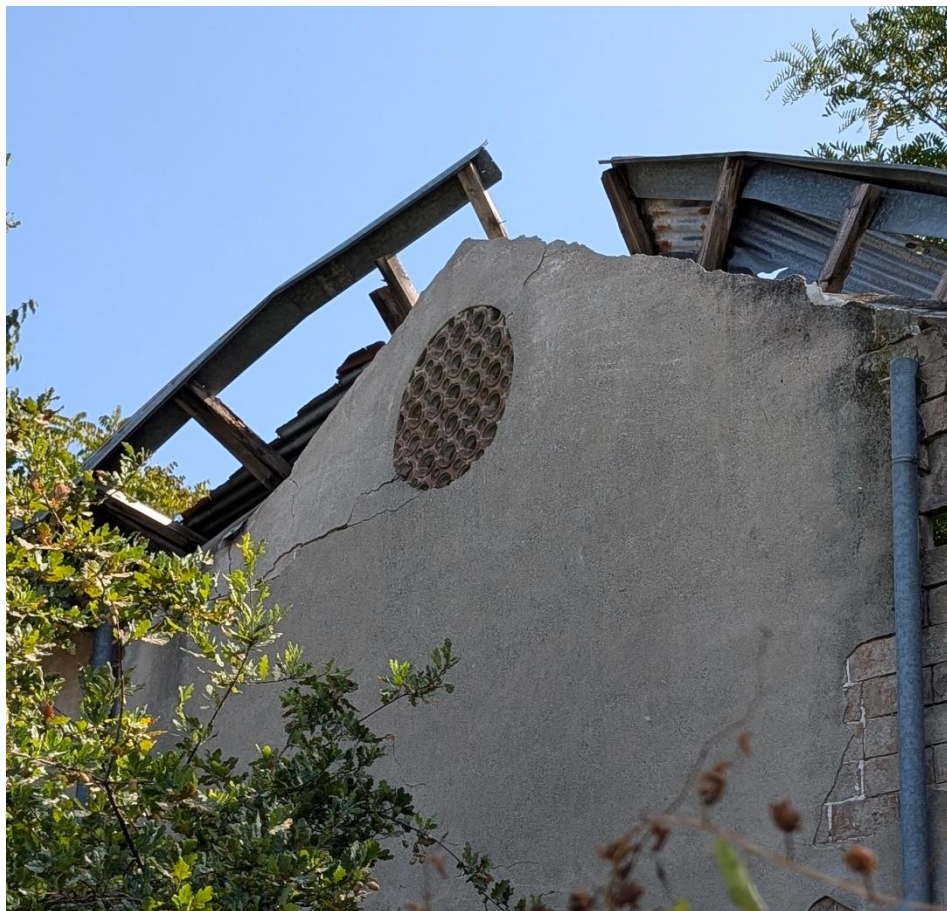
Figure 47 e 48. Il basso comodo con la muratura in foglio prossimo al collasso
