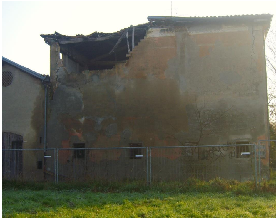
Figura 2b. Il fianco Ovest della parte produttiva dopo i primi collassi strutturali (novembre 2011)
